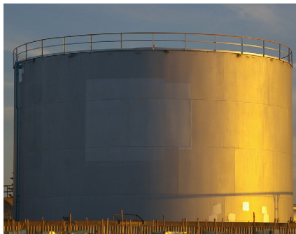
Tanque de alcohol / etanol, instalación directa en la cima o vaso comunicante.
