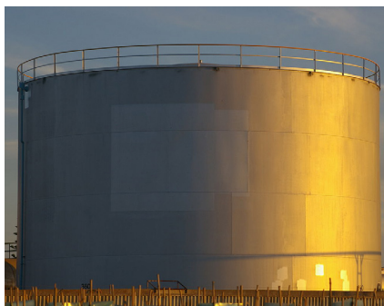
Tanque de álcool/etanol, instalação direta no topo ou vaso comunicante.
